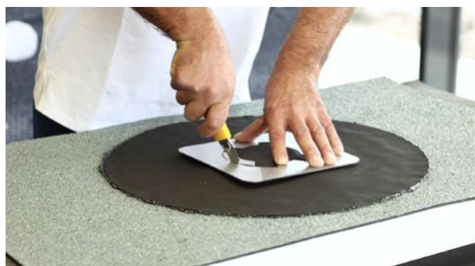
Ausschnitt mit BefTec® Schneidelehre durchführen
