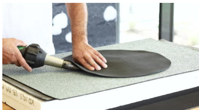
Rondelle mit Bitumen-Dachbahn verbinden*
