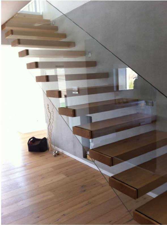
Sicherheitsglas-Brüstungen setzen sich in Neu- und Altbauten immer mehr durch, denn sie schaffen offene, lichtdurchflutete Räume und werten in Kombination mit Holz oder Metall das Ambiente auf. Glas eignet sich im Innenbereich für Galerien und Treppen und außen für Balkon- und Terrassenbrüstungen.
